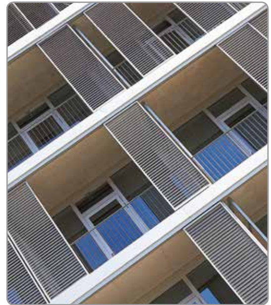
Loggia®, Centre de services intégrés de soins pour seniors, residential, Luxemburg (LU)
