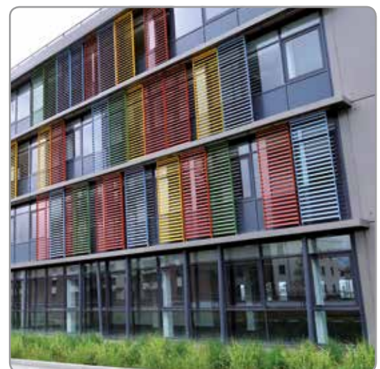
Patio®, Colombe Parc Offices, Toulouse-Colomiers (FR)
